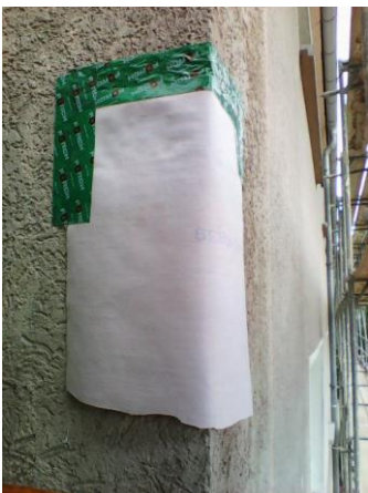
Beispiel für eine Spechtlochvergrämung mit Dachdeckerfolie
